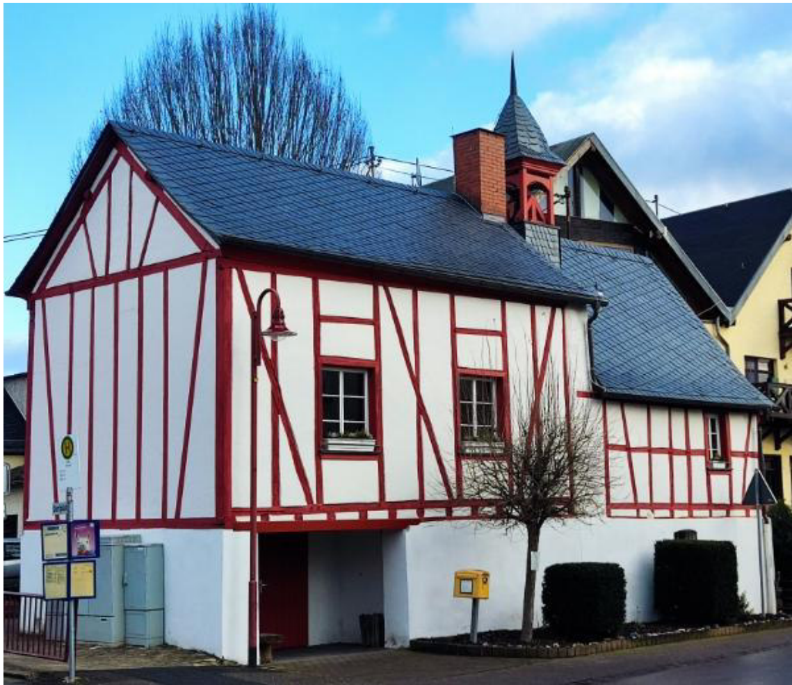
Bild 3: Ehemaliges Mehrzweckgebäude (Backhaus), erbaut 1838 mit Schulsaal und angegliederter Lehrerdienstwohnung im Obergeschoss
