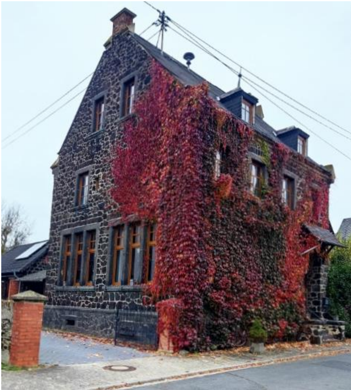
Bild 5: Ehemaliges zweites Schulgebäude, erbaut 1904; mit Schulsaal unten und Lehrerdienstwohnung im Ober- und Dachgeschoss
