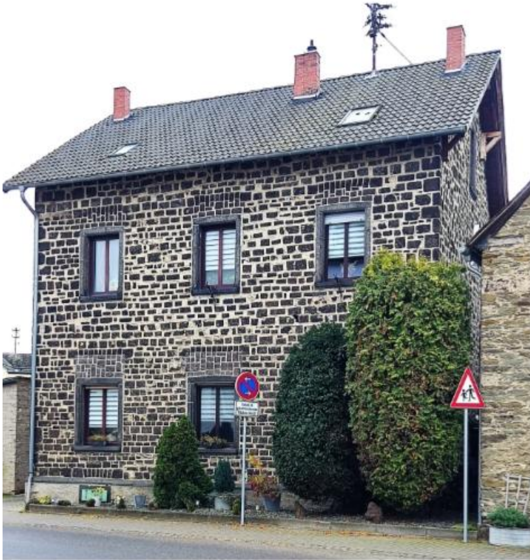
Bild 4: Ehemaliges erstes Schulgebäude, erbaut 1879; mit Schulsaal unten und Lehrerdienstwohnung im Ober- und Dachgeschoss
